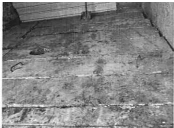
事故应急池（地埋式）
